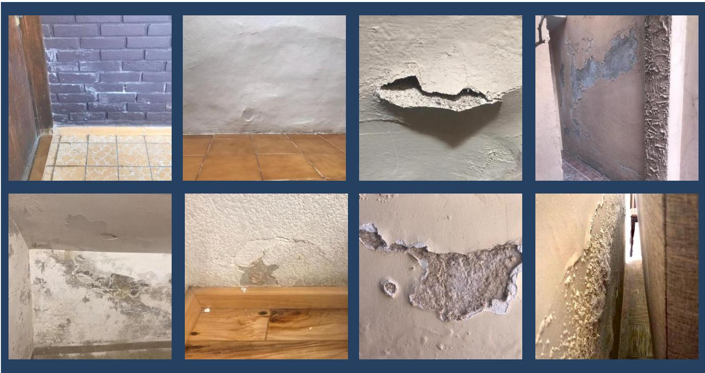
El **salitre** no proviene de las sales propias de los materiales de construcción sino de las sales del subsuelo que son transportadas por el agua que sube del subsuelo llamada “Humedad Ascendente”, “Humedad por Capilaridad” o “Humedad del Subsuelo”.
